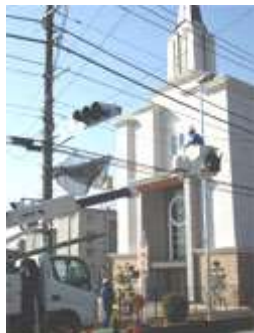
高所作業車にて引込 口工事中
