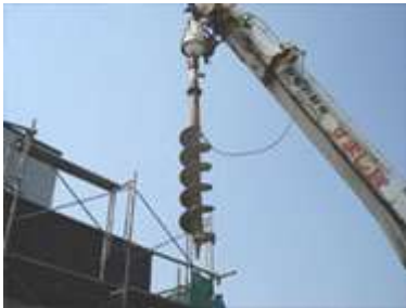
重機にて穴掘作業開始
