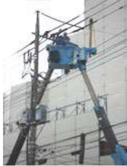
無停電にて工事中
