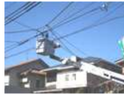
高所作業車にて修繕 工事中
