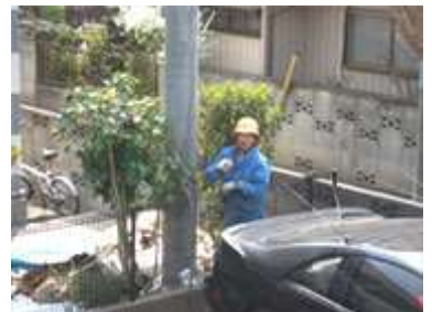
電柱(基地局およびCP柱) 新設工事後
