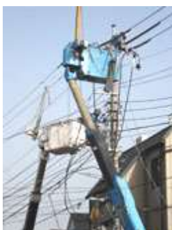
工事前無停電工事準備
