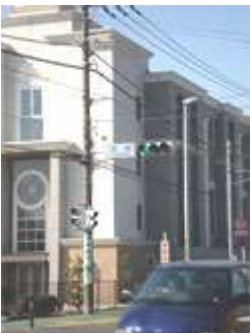
交差点の中、工事前
