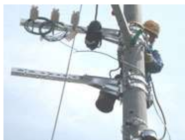
高圧1号柱 PAS,SOG 取付工事
