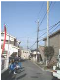
電柱建替後電線移設前
