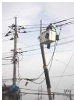
無停電工事準備
