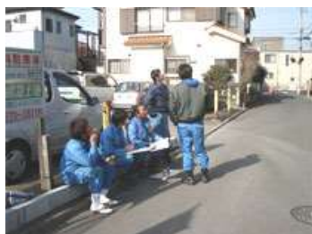
電柱建替工事前
