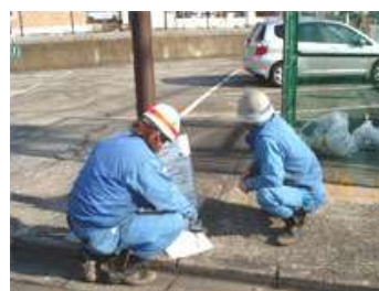
引込線改修工事前
