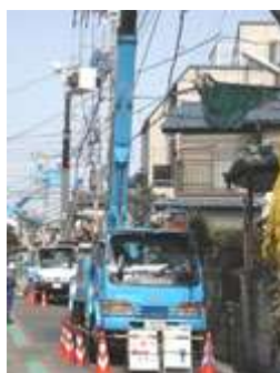
低電圧隔離不足改善のため、SV(ケーブル化)に取り換え
