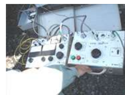
配線工事の現場
