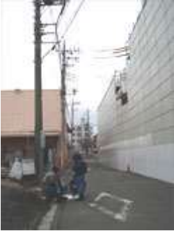
工事前高圧引込 ケーブル化
