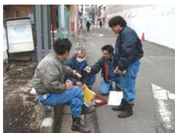
受電引込工事前
