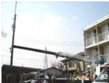
電柱(基地局およびCP柱) 新設工事中
