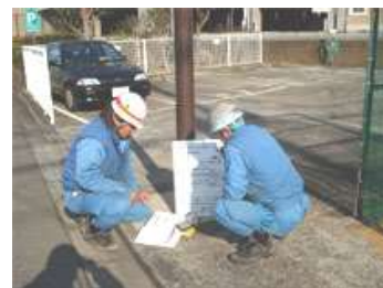
外灯供給工事前
