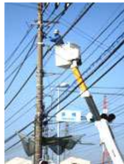
電源側工事中
