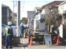
高所作業車両準備
