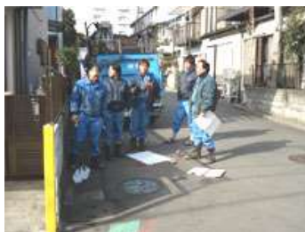
電線張替工事前
