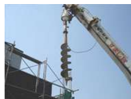
一般工事・携帯電話基地局工事の現場
